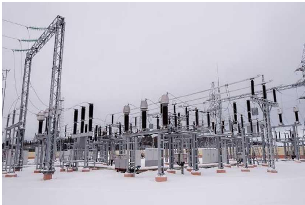
Строительство ПС 110/10 кВ «Боровуха» с ВЛ-110 кВ.
