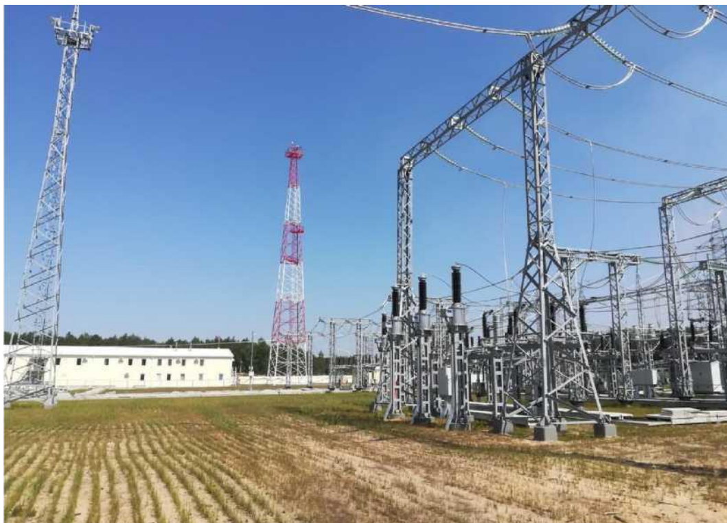
Строительство ПС 110 кВ «Островец-Восточная» с ВЛ 110 кВ в связи со строительством АЭС в Республике Беларусь;
