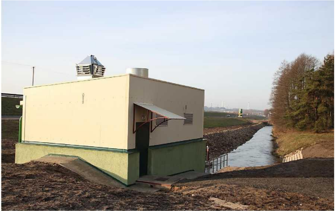
Реконструкция Зельвенской ГЭС (0,11 МВт).
