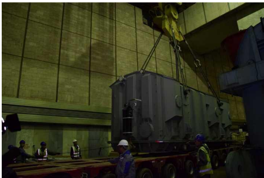
Замена трансформатора Т-3 Токтогульской ГЭС на новый
