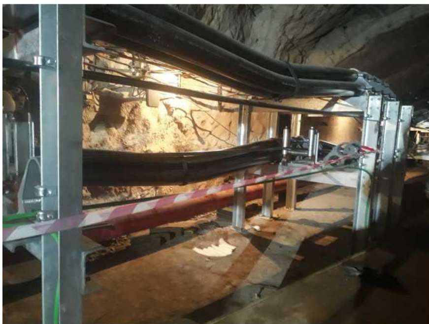
Замена кабельной линии 500 кВ Токтогульской ГЭС
