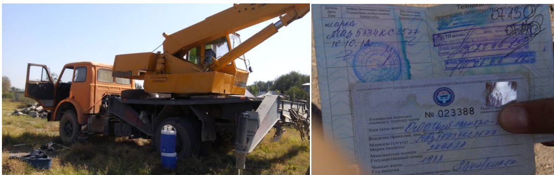
Фото №5. Свидетельство о прохождении технического осмотра техники, работающей на прокладке оптоволоконного кабеля
